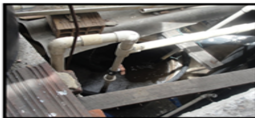
Foto No. 4 Vista superior del tanque de
